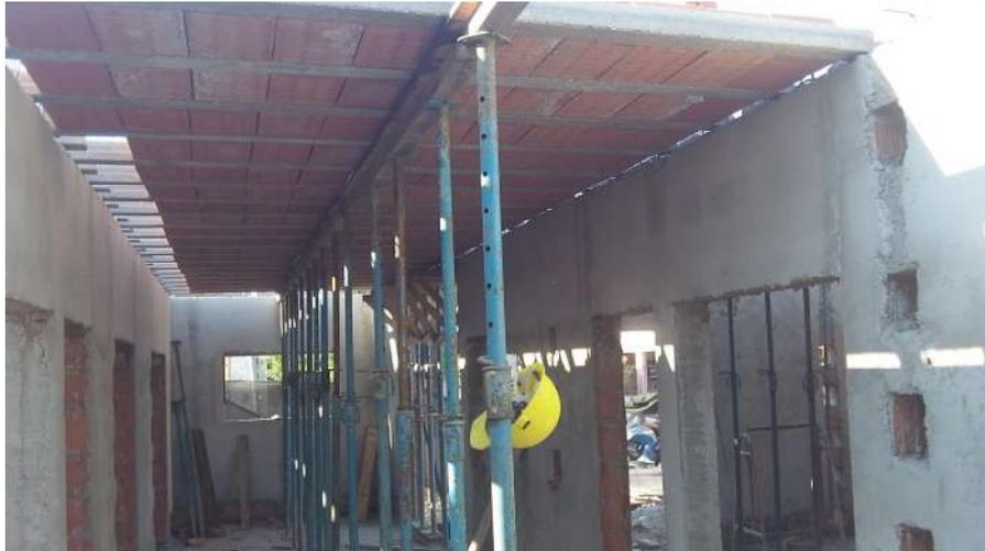
Imagen interior, pasillo de distribución - Armado de losa de viguetas
