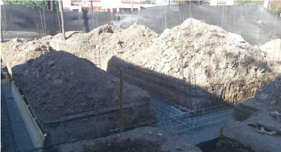
Imagen de fundaciones edificio - Zapata corrida
